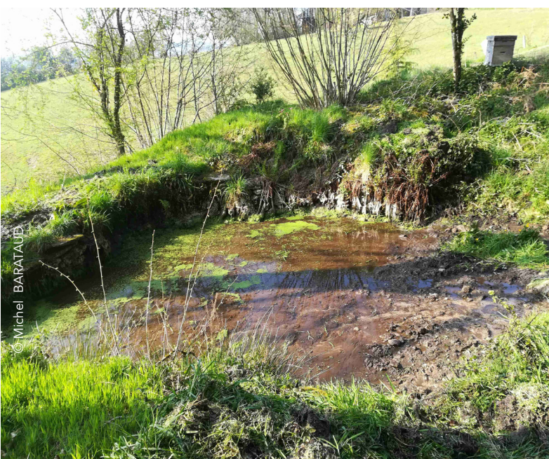
Curage du fond de la mare et colmatage des fuites (mars 2021).
